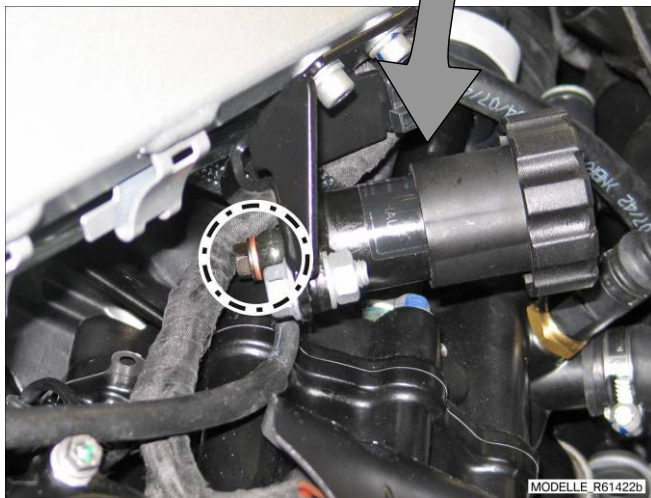
液圧式リアサスペンション調整装置のボルトと配線の干渉部位
